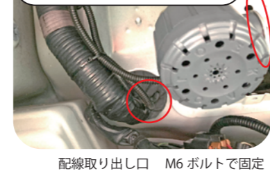
車両後側用アラート取付
